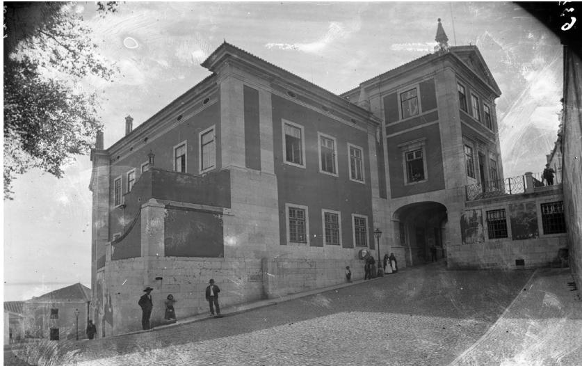
Antiga fachada Este, Hospital da Marinha
